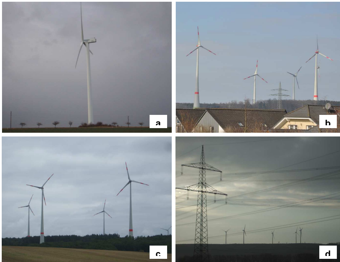
Figure 1. Foto-Illustrationen zur Problemstellung. (a) Neue Windkraftanlagen, zumeist über 200m hoch, sind neue alles überragende Landmarken. Diese raumprägende Dimension hat es zuvor nie gegeben. (b) Sie überragen in teils engen Abständen die Siedlungen im ländlichen Raum und (c) werden als Windparks zunehmend auch in naturnahe Wälder und wertvolle Lebensräume gebaut. (d) Folglich entsteht dezentral, multiplikativ und fast flächendeckend eine dominante ‚Energiewirtschaft‘: ein extremer Landschaftswandel, der quer durch alle unterschiedlichen Räume geht und diese letztlich nivelliert, verbunden mit Chancen und Problemen laut Textteil (Fotos von Michael Altmörs, a und d aus dem Raum Alzey/Rheinhessen, b und c rund um Kirchberg/Hunsrück – Rheinland-Pfalz).
